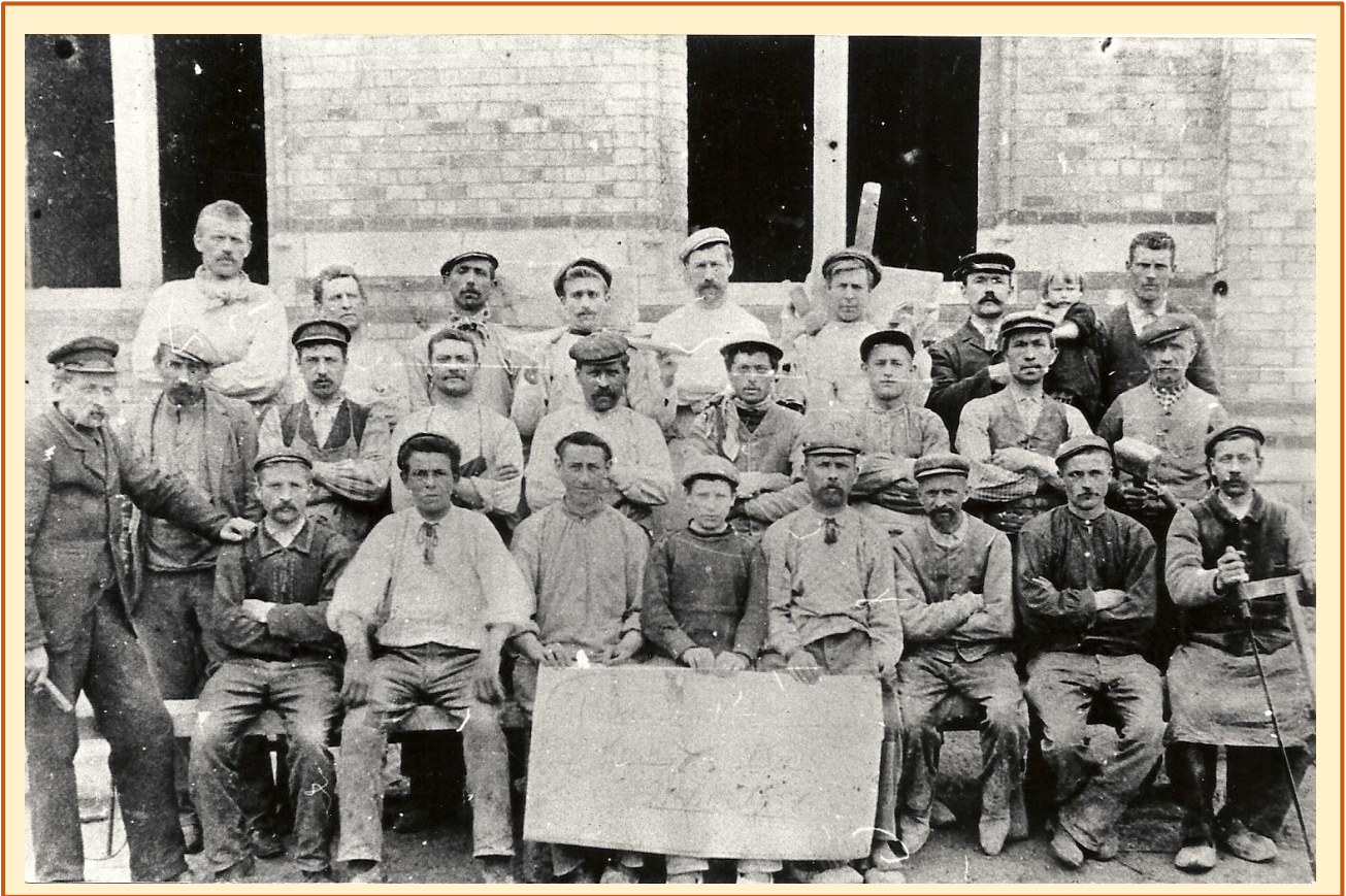
De ploeg metselaars en schrijnwerkers van de firma Verstraete uit Rumbeke, vóór de werf van de nieuwe Pamelse kerk (1903).
